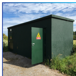
NRO (Noeud de Raccordement Optique)
