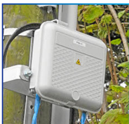
PBO (Point de Branchement Optique)
